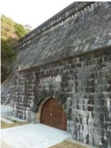
（写真）堤体下流面
