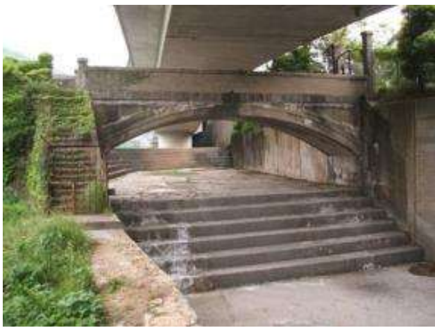
（写真）ダム放水路橋。日本初の鉄筋コンクリート橋です。
