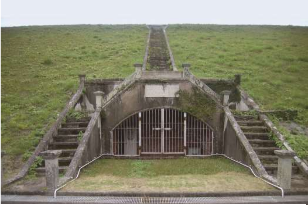
（写真）堤体下流面
