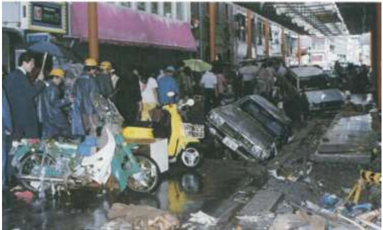
④ 浜町アーケード被災状況
