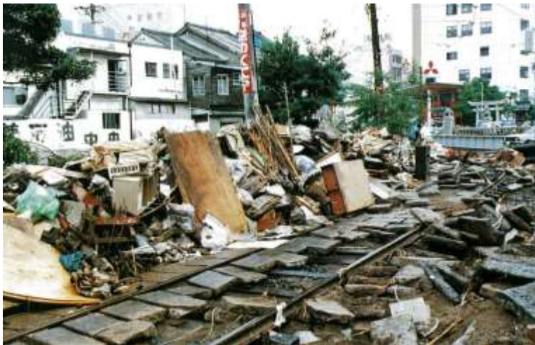
③ 賑橋付近の路面電車軌道被災状況
