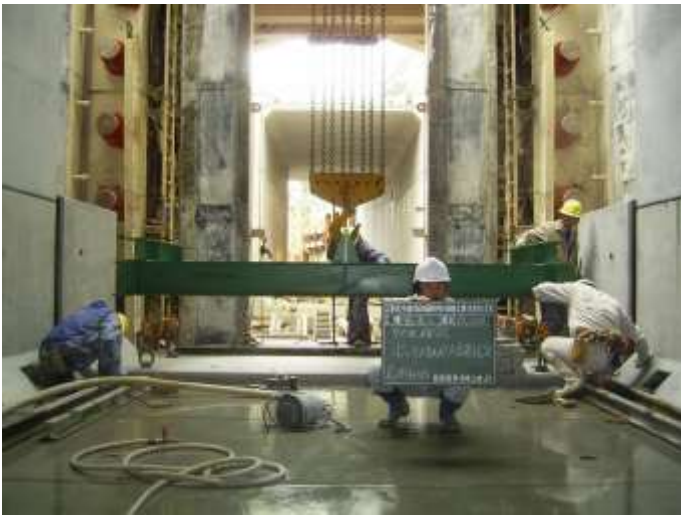
(底版据付状況)
