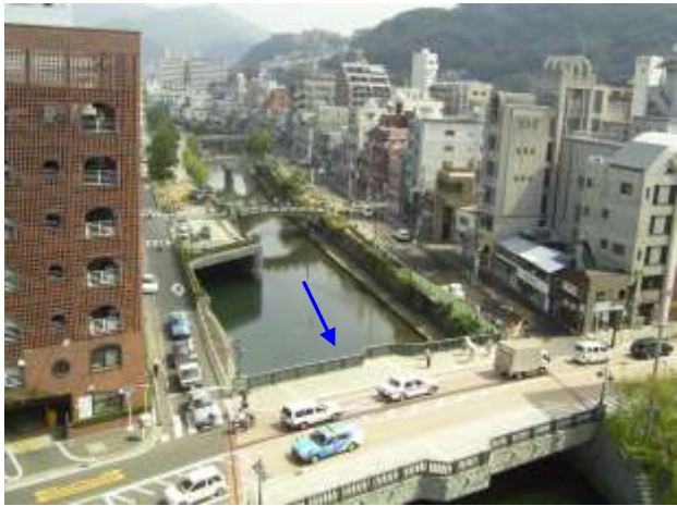
(左岸バイパス着工前)
