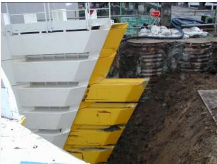
(シールドマシン掘削状況)
