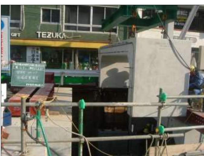
(頂版据付状況)
