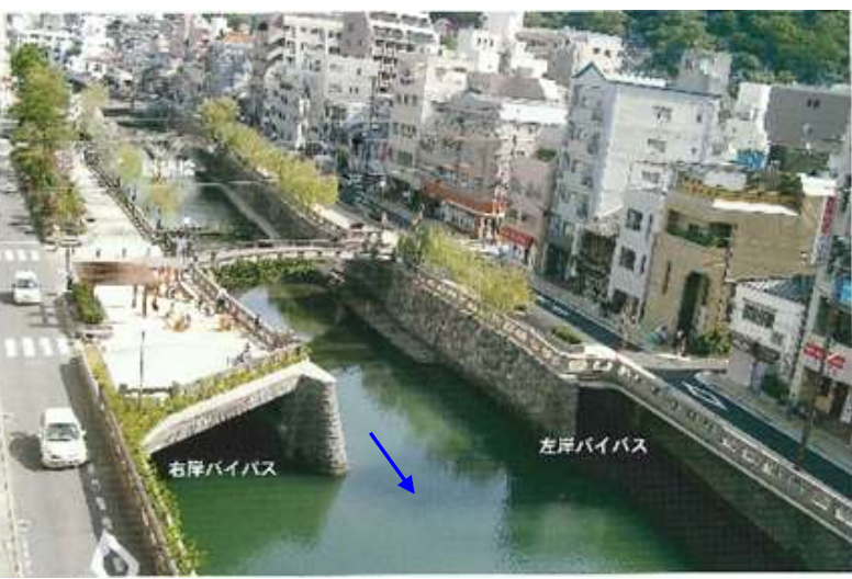
(左右岸バイパス水路完成)
