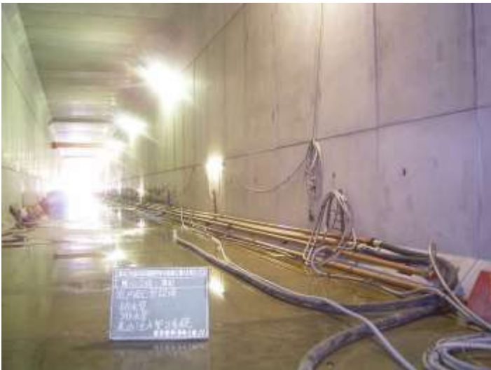
(据付完了状況)
