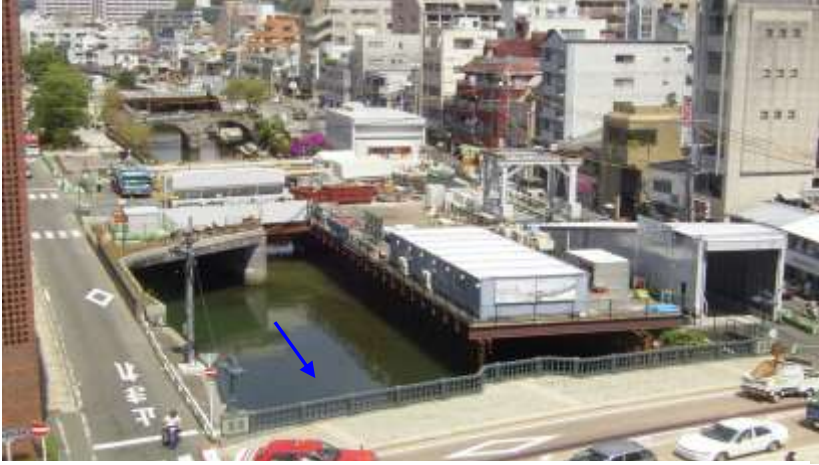
(左岸バイパス施工中)
