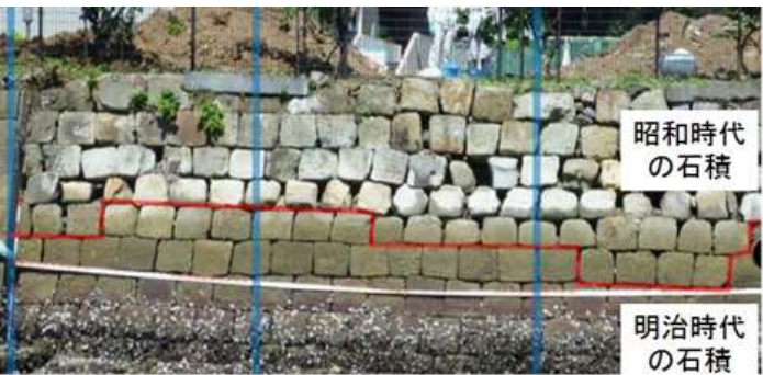
（改修前の石積護岸状況）
