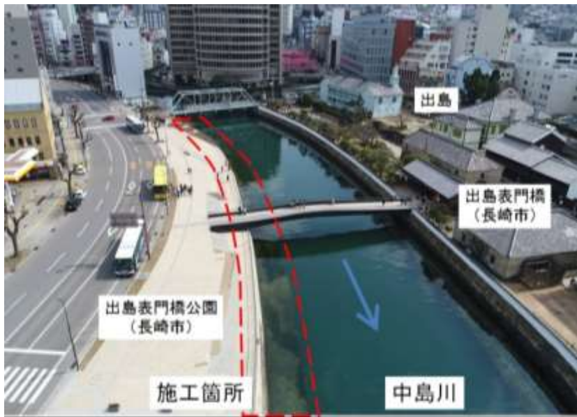
（工事箇所全景）
