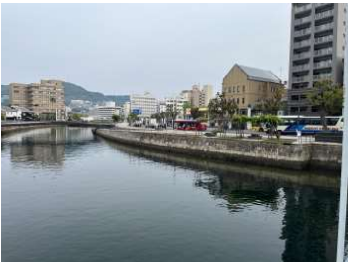
（改修工事完了後の石積み護岸）
